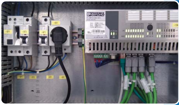
Bild 1: Insgesamt wurden bei ZF Sachs 40 dezentrale Maschinennetze eingerichtet und jedes dieser Teilnetze durch eine mGuard Firewall von Phoenix Contact und Innominate abgesichert.
