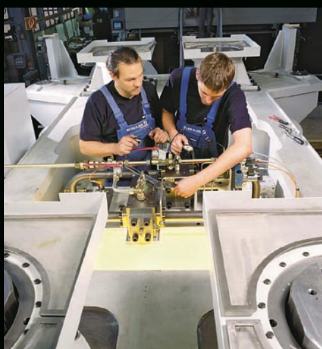
Remote Services von Anfang an: Bei der Montage einer Schuler-Großpresse werden die Datenleitungen für die Fernwartung gleich mit verlegt.
